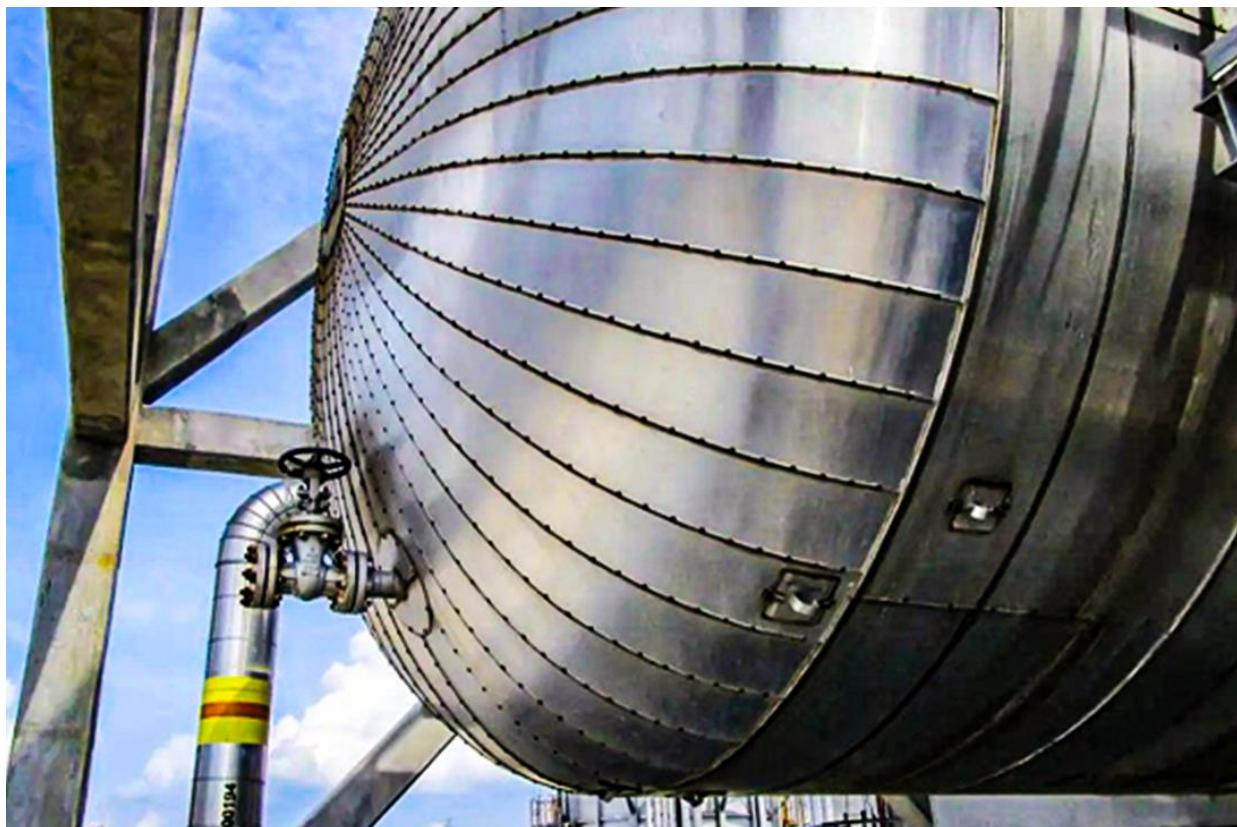
在蒸馏塔的预热系统中，一个预闪蒸罐系统将预热前产生的蒸汽与加热器或主蒸馏塔分开。这样可以防止加热器过热的燃烧或压力下降，减少蒸馏塔的蒸汽负荷，以免水淹。
