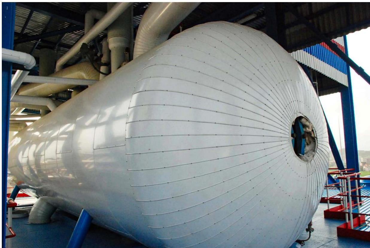
汽包是水和蒸汽之间的主要接口。在燃煤电厂中，锅炉给水通过省煤器，进入汽包，蒸汽从给水中分离出来，并被转移到过热器。在燃气-蒸汽联合循环运行中，余热回收蒸汽发生器（HRSG）与锅炉的作用相同。它是一种气-水热交换器，从燃气轮机废气中提取能量，并用它加热蒸汽发生器产生蒸汽。HRSG 汽包是可以承受高低压变化的。
